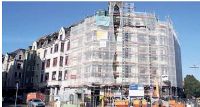
Bis Anfang November soll das Haus Schleusenstraße 33 winterfest sein.
