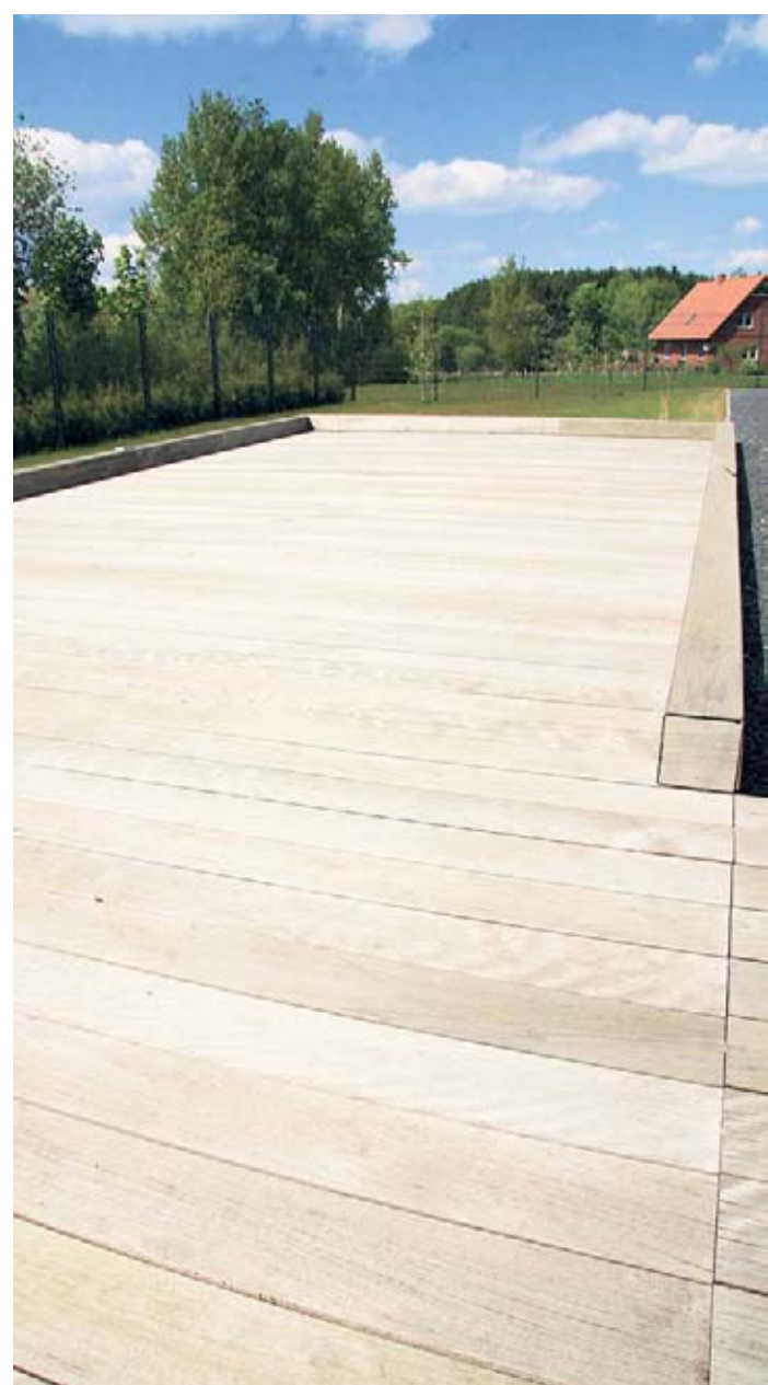
Auch im Außeneinsatz kommt Thermoholz gut zur Geltung.
